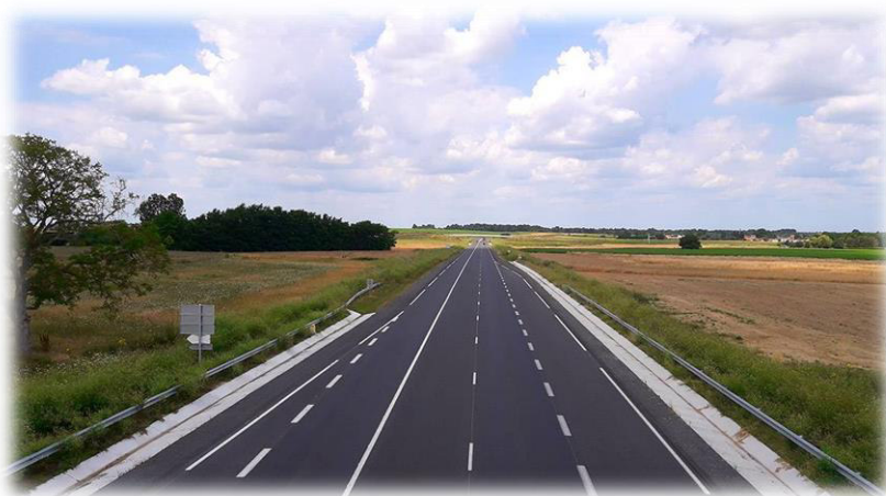
Source : Charrier TP, déviation de la RD 938 à Brion-Près-Thouet.
